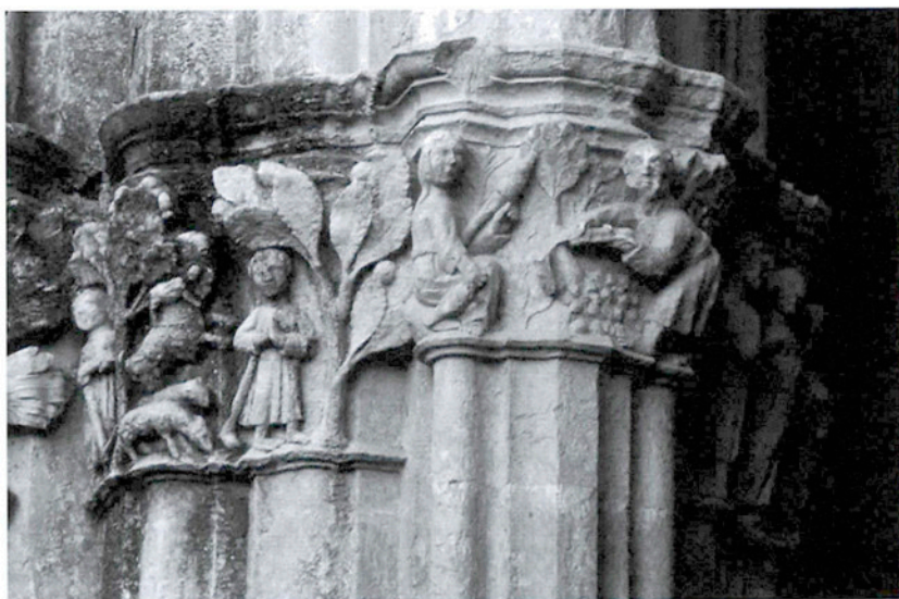
FIGURA 2. Pilar de l'angle sud-oest. Cicle del Gènesi.
